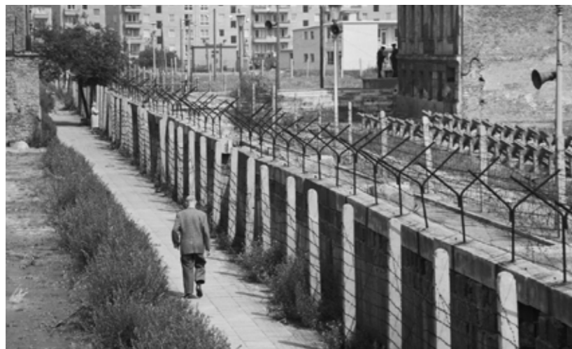
↑ Berli fal építése
