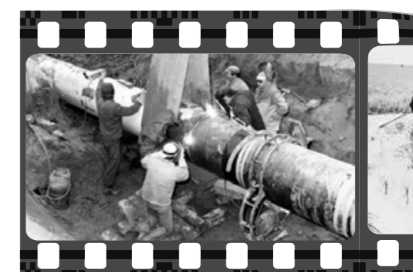
- Barátság Kőolajvezeték építése
